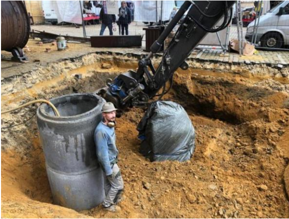
Le moule réalisé à Strasbourg est enterré dans un trou de 4 m de profondeur place Léopold
