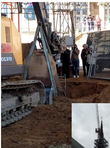
Mercredi 2 octobre : la cloche est déterrée puis démoulée. Elle pèse 1850 kg
